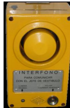
Figura 30: Interfono montado en carcasa.
