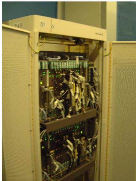
**Figura 4.13.:** El bastidor BYB 501 que aloja los elementos del *core* real de Ericsson para testeos y pruebas.
