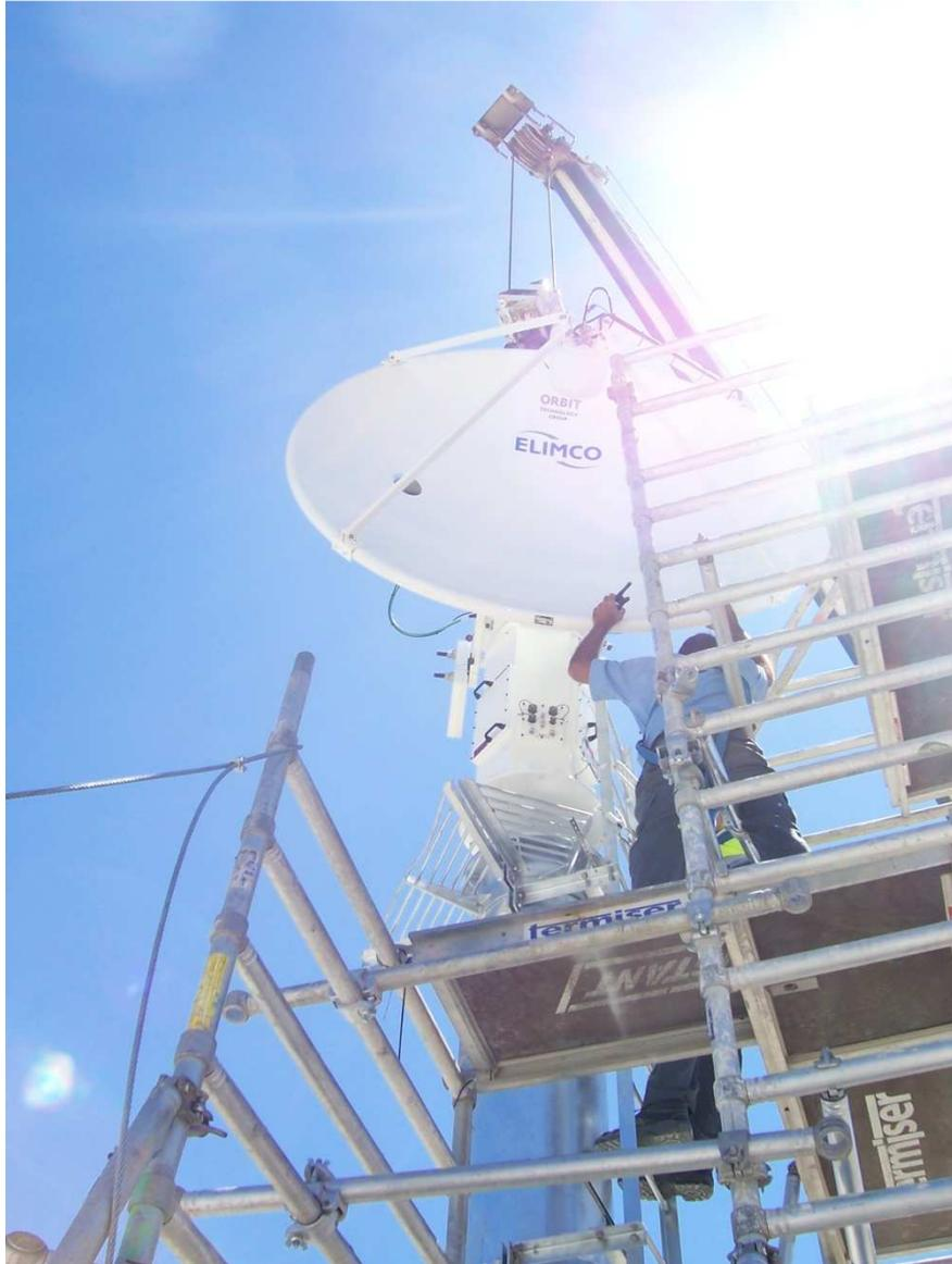
**Figura 2: Colocación del sistema pedestal-antena**
