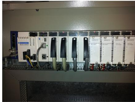
Figura 3.1.2: Fotografía del bastidor con el autómata programable M340 y sus módulos.
