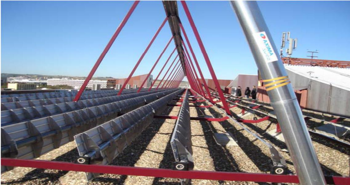
Ilustración 4. Estructura de acero del colector solar
