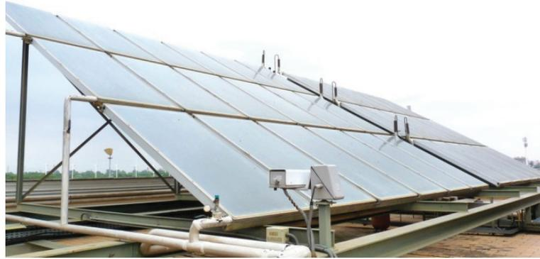
Figura 2.4: Captador plano situado en el edificio de laboratorios de la Escuela Superior de Ingenieros de Sevilla.
