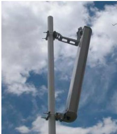
Figura 19. Pieza para downtilt mecánico
