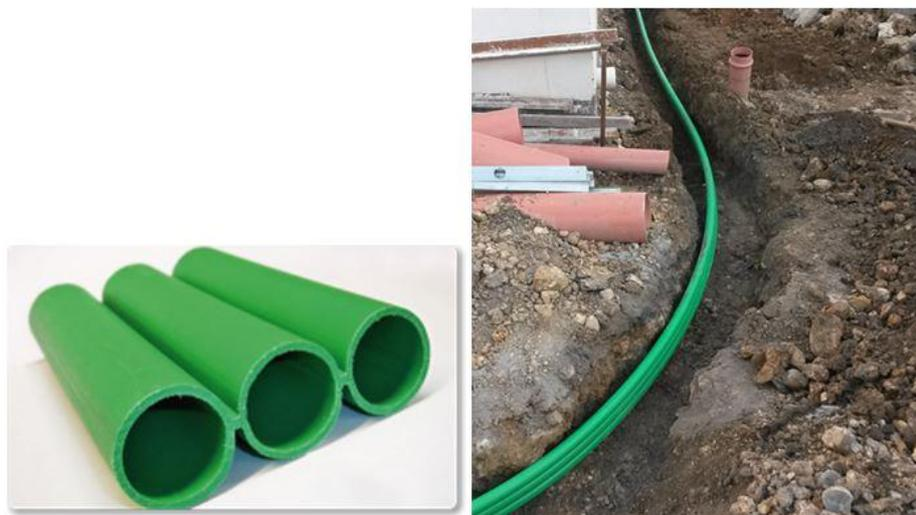
Figura 26: Ejemplo de subconductos.
