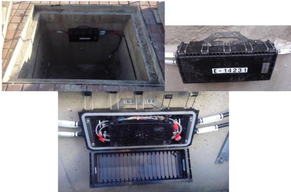
Figura 15: Ejemplo cajas de empalme
