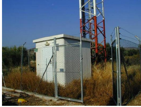
Figura 31. Fotos emplazamiento N01.
