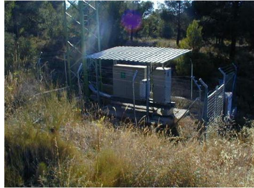
Figura 44. Fotos emplazamiento N14.
