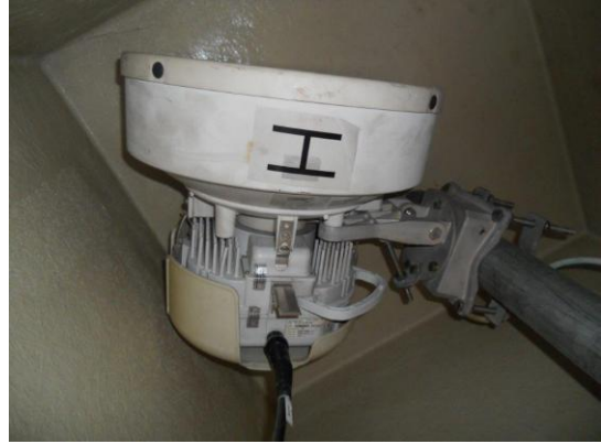
Figura 33. Fotos emplazamiento N03.
