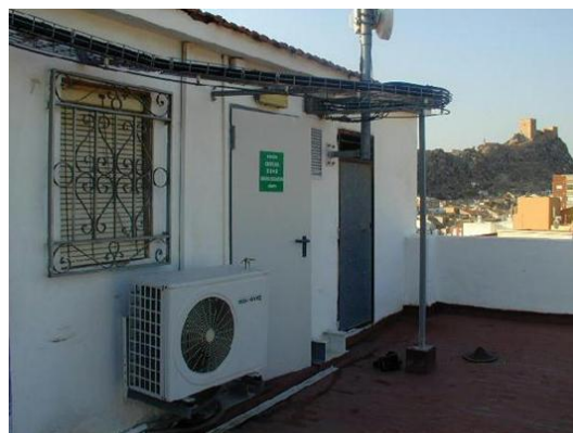
Figura 32. Fotos emplazamiento N02.
