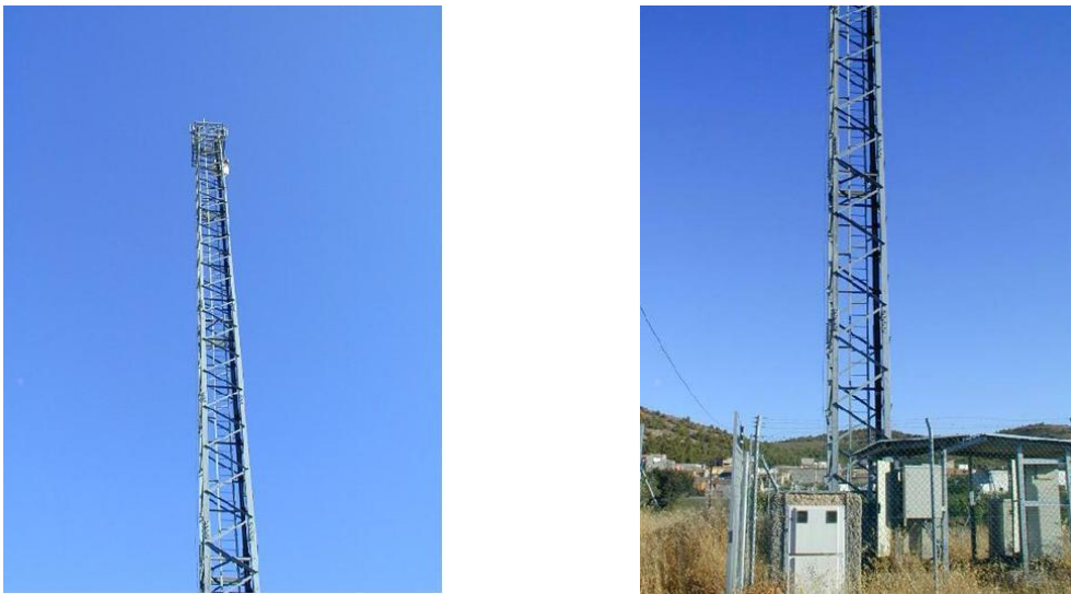
Figura 41. Fotos emplazamiento N11.
