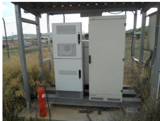
Figura 36. Fotos emplazamiento N06.
