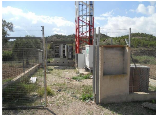
Figura 34. Fotos emplazamiento N04.
