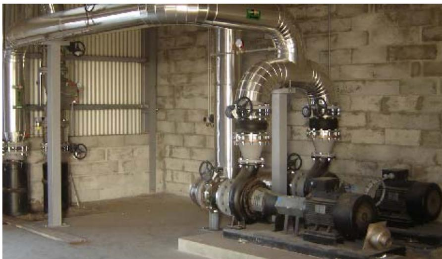
*Imagen 1.4. Conjunto de dos bombas paralelas para la distribución de agua en la red del grupo caliente.*
