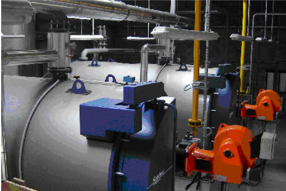
*Imagen 1.3. Calderas de gas natural para la producción de agua caliente.*
