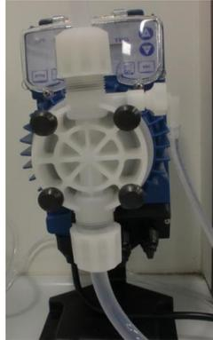
Ilustración III-7. Bomba del circuito de orgánico.
