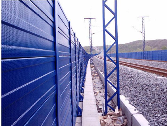
**Figura 2.2.11: Pantalla acústica metálica Grupo Postigo.**
