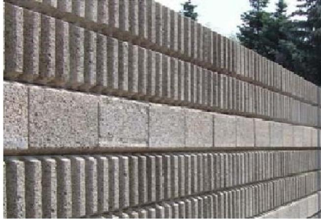
**Figura 2.2.9: Pantallas hormigón Climablok.**
