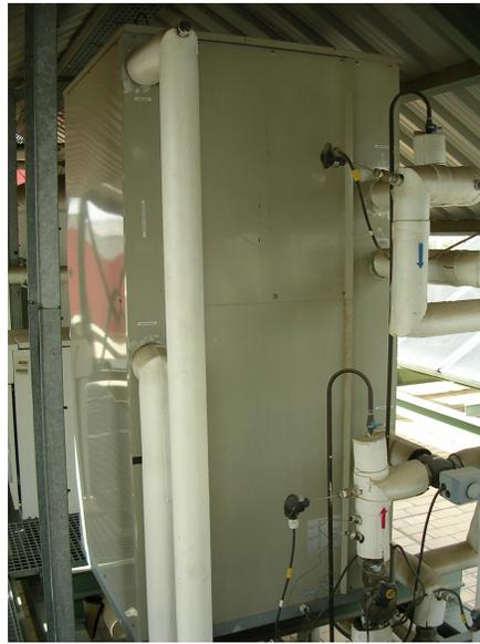
**Figura 2.5 Máquina de absorción.**
