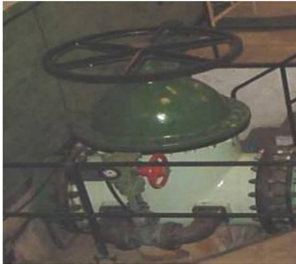
**Figura 8. Válvula de entrada a grupo de la central hidroeléctrica de Ronda (Málaga).**
