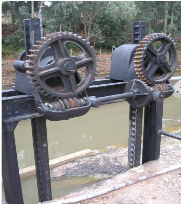
**Figura 7. Accionamiento de las compuerta de limpia del azud de la central hidroeléctrica de Buitreras en Cortes de la Frontera (Málaga).**
