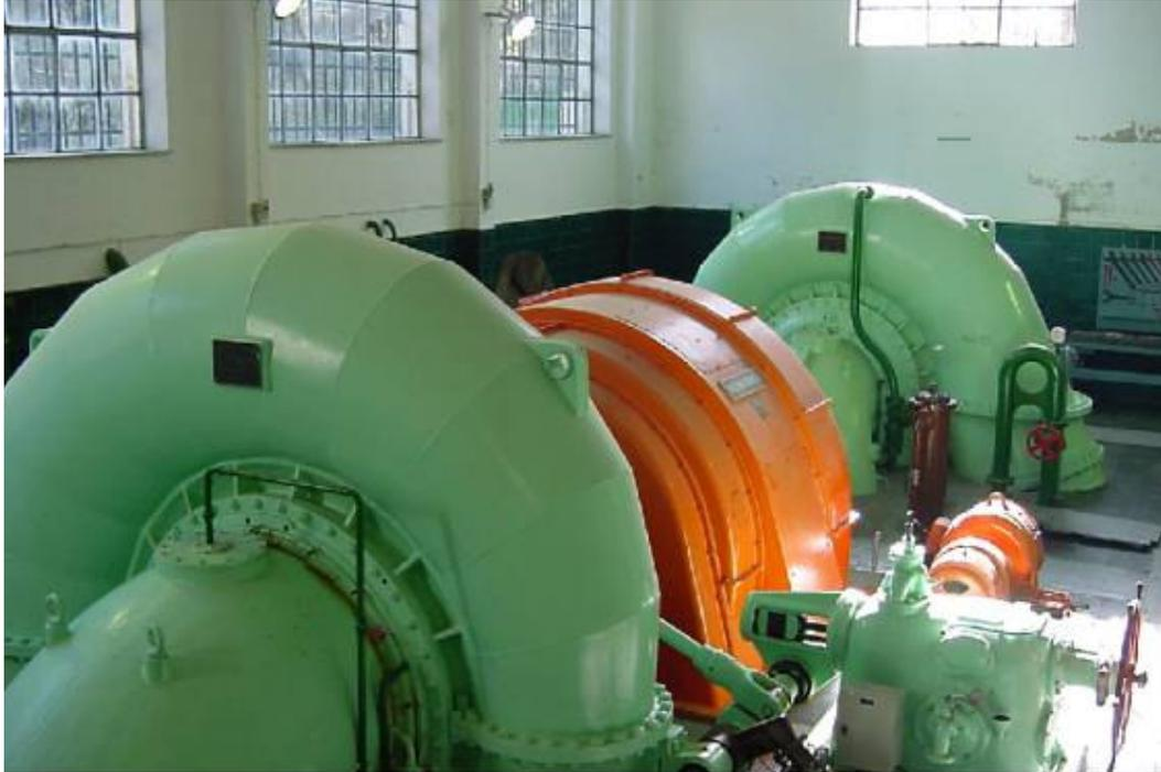
**Figura 10. Turbina Francis y alternador horizontal de la central hidroeléctrica de Gobantes en Ardales (Málaga).**
