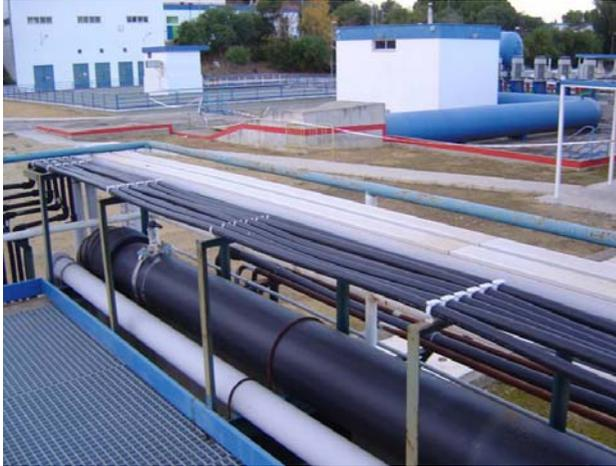
*2. Tuberías de PE: efectos de la dilatación térmica.*
