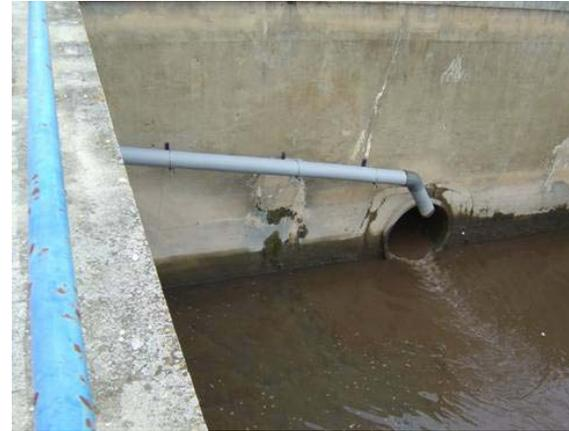
*3. Tuberías para transporte de agua con cloro*
