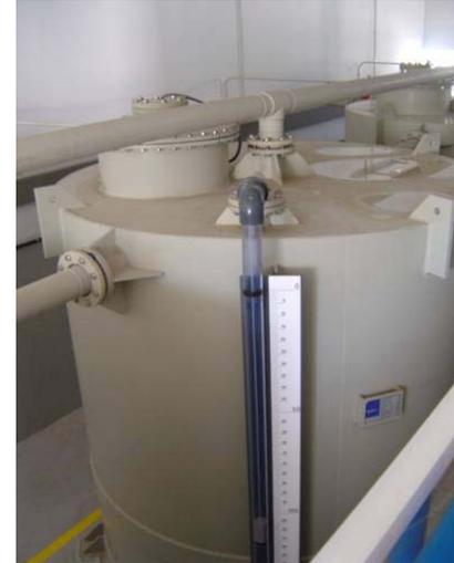
*3. Tuberías para dosificación de ác. hexafluorsilícico*
