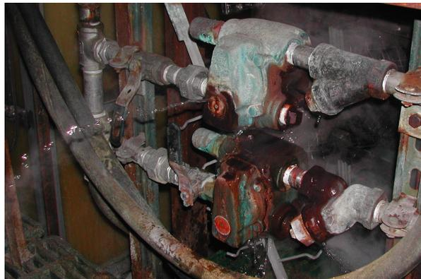
*Fig. 2.15. Purgador en mal estado que deja escapar vapor y condensado.*
