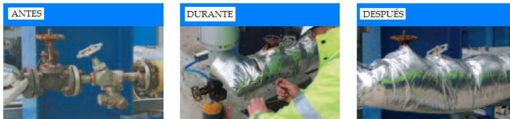
Fig. 2.19. Aislamiento de accesorios con envoltura aislante.
