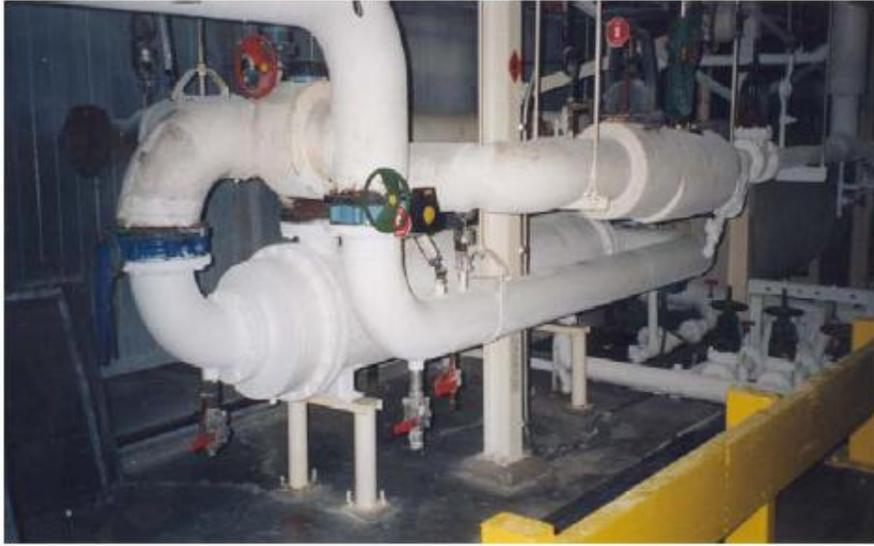
Fig. 2.26. Ejemplo de instalación recubierta con aislante cerámico.
