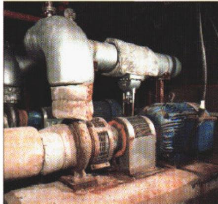
Fig. 3.49. Bomba de distribución del condensado.
