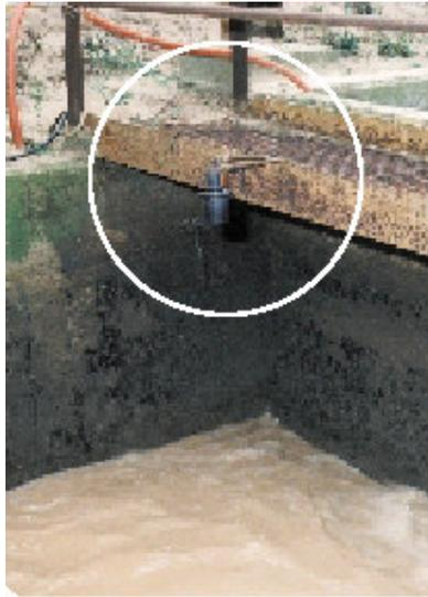
Fig. 3.56. Sensor ultrasónico de nivel del efluente.
