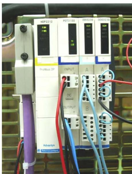
**Figura 5.16 - isla de automatización de nuestra instalación**
