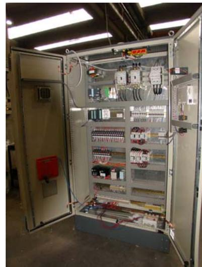
Fig. 3.10. Armario eléctrico
