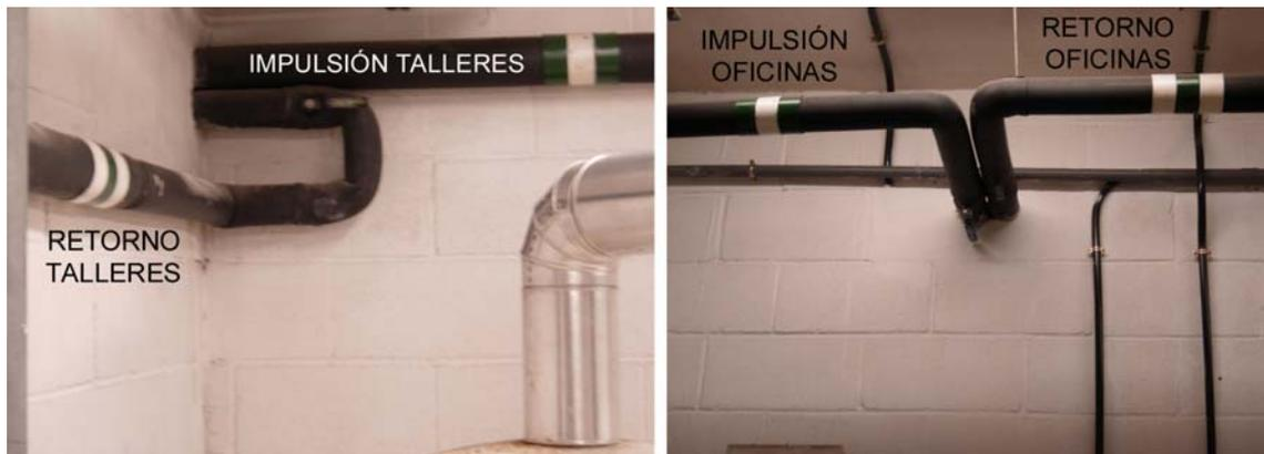
Fotografía 10 - Tuberías de impulsión y retorno de talleres y oficinas
