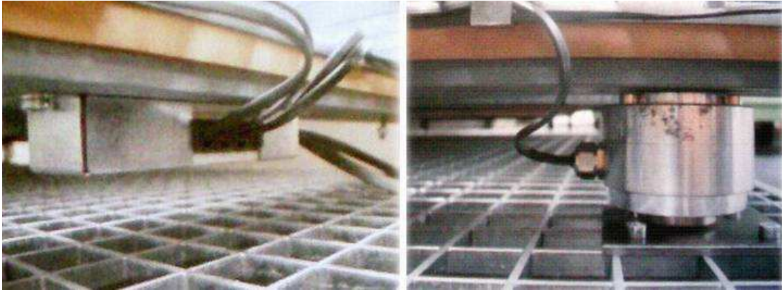
Figura 3: Montaje del uno de los sensores entre los dos emparrillados y montaje de la placa de adquisición de datos
