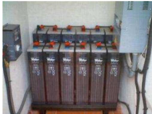
Figura 2.2. Baterías estacionarias de Plomo-Ácido
