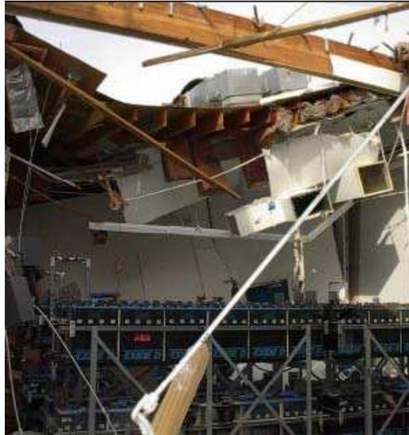
Gráfica 2.2. Explosión debida a una fugas de gases en una batería que reventó el tejado de un centro de datos en Sacramento [19].
