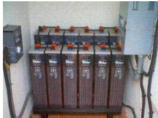
*Figura 2.1. Baterías estacionarias de plomo-ácido*
