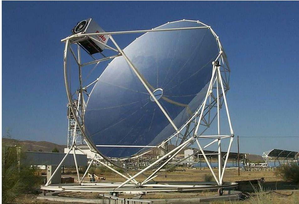
Figura 22. Sistema de disco solar Stirling EuroDish
