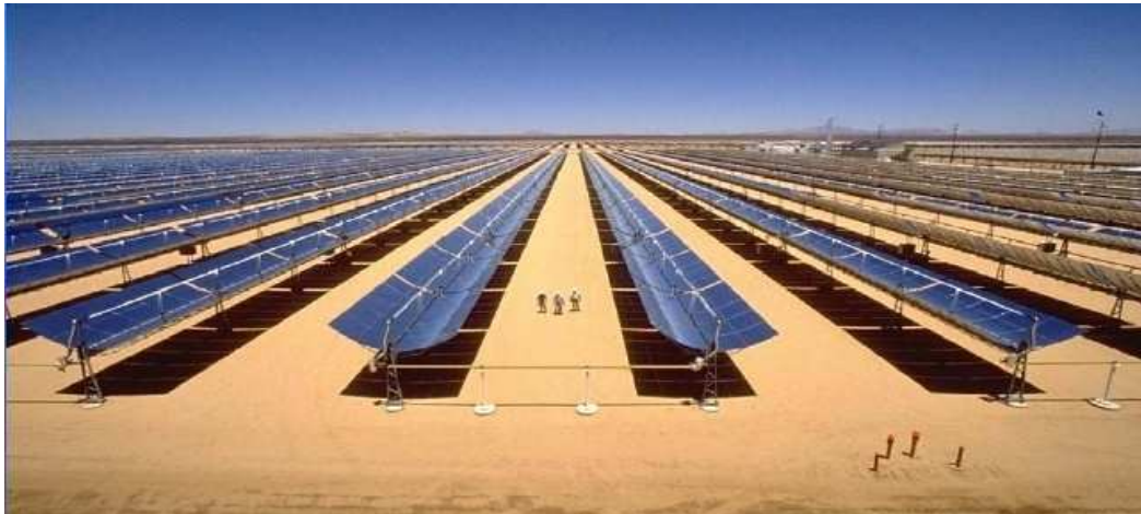
Figura 3.1.1. Vista de un campo típico de captadores de canal parabólico
