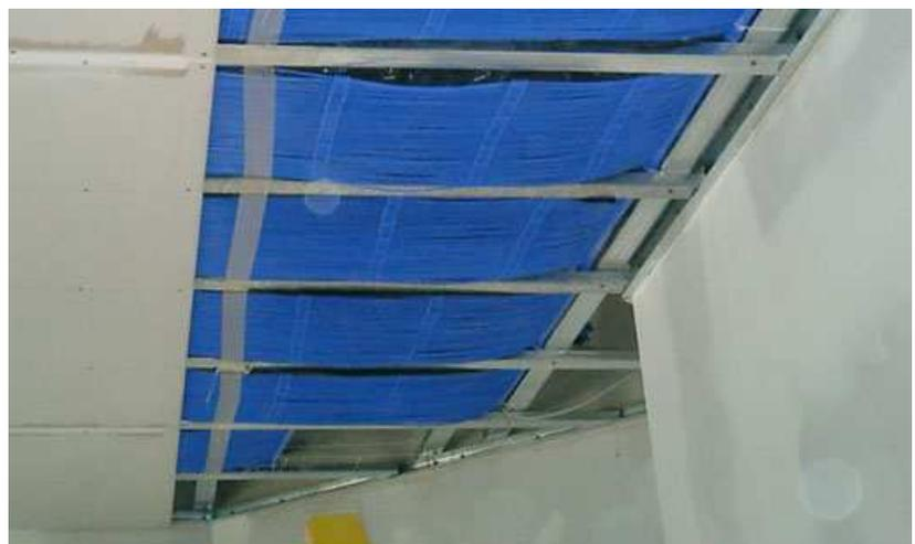
**Figura 19. Conductos capilares dispuestos en el techo antes de aplicarse el enlucido**
