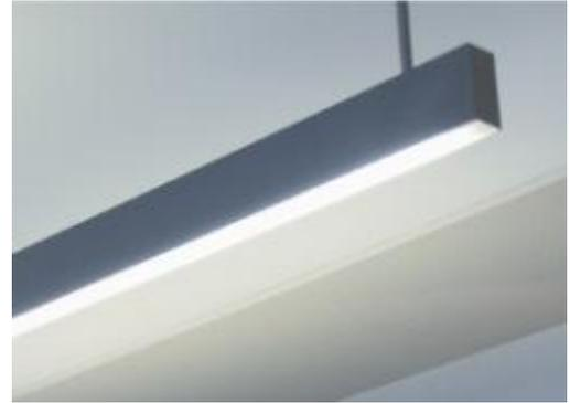
4. Philips PerfomaLux HPK380 los empleados en la zona de proceso. Cuelgan con cables de acero.
