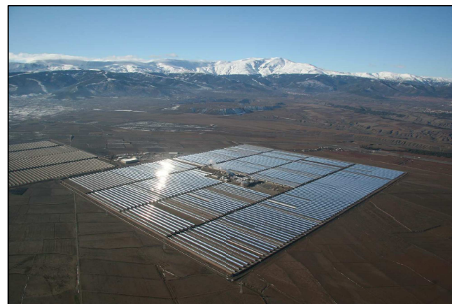
CAMPO SOLAR DISEÑADO CON COLECTORES CILINDRO-PARABÓLICOS MODELO SKAL-ET 150
