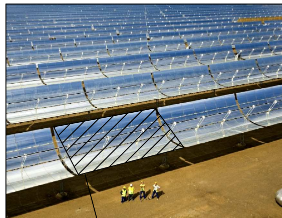
CAMPO SOLAR DISEÑADO CON COLECTORES CILINDRO-PARABÓLICOS MODELO SKAL-ET 150
