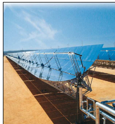
CAMPO SOLAR DISEÑADO CON COLECTORES CILINDRO-PARABÓLICOS MODELO SKAL-ET 150
