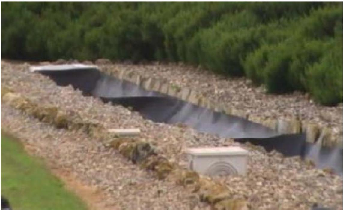
Fig. 13 Impermeabilización del canal.
