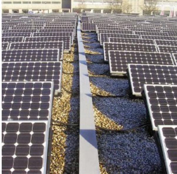
*Figura 6.2: Canaletas UNEX en la instalación*
