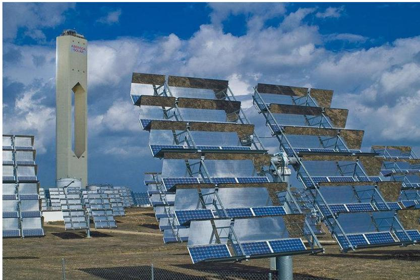
Figura 7. Sistema de receptor central.
