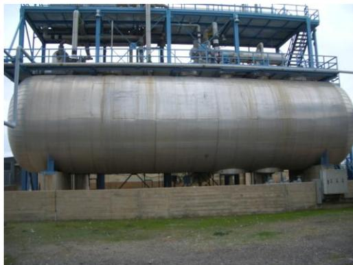
Figura 26. Tanque de almacenamiento de sales ensayado en la PSA.
