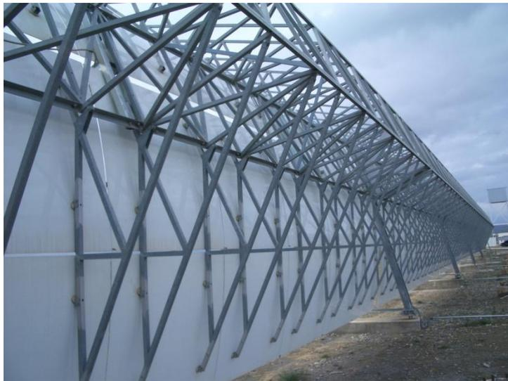
Figura 16. Vista de la estructura del captador EURO TROUGH en posición de abatimiento
