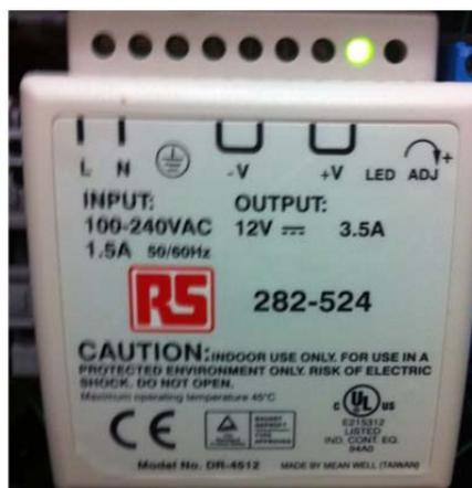
Ilustración 53 - Fuente auxiliar de 12VDC
