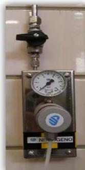
**Ilustración 57 - Punto de consumo de nitrógeno**
