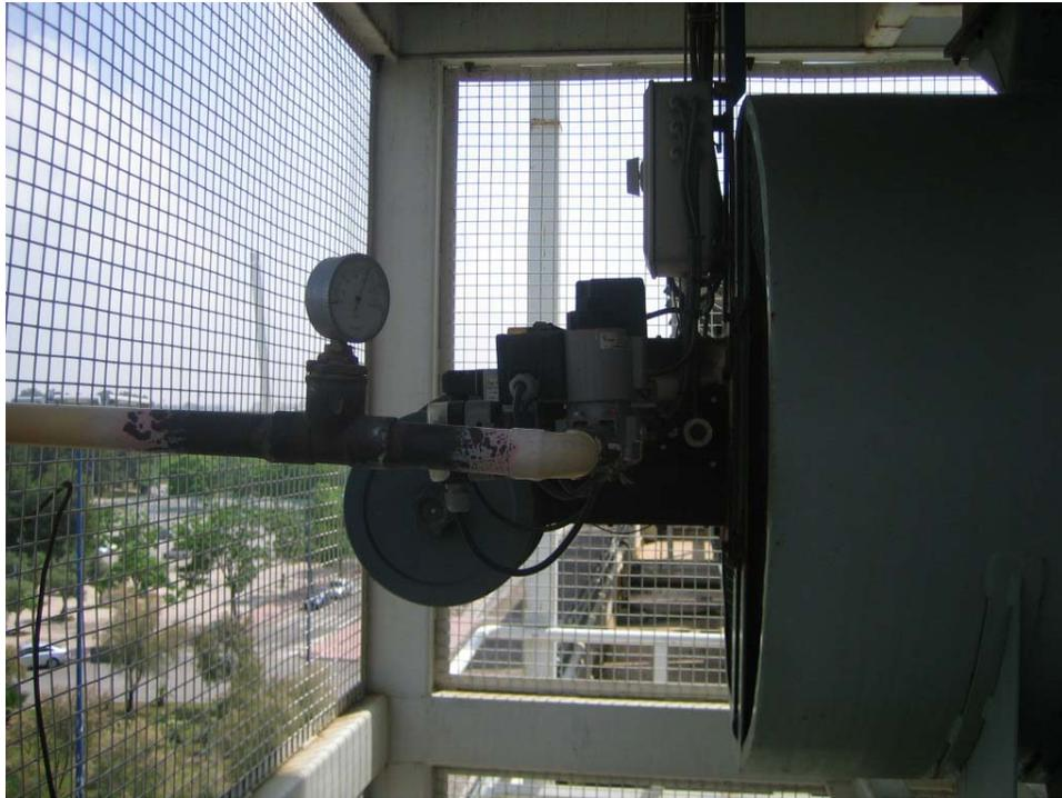
**Figura 4.6 - Detalle del quemador**
