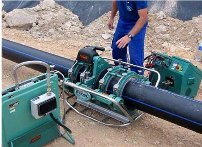
Figura 4.59 – Operario realizando una soldadura a tope (16)
