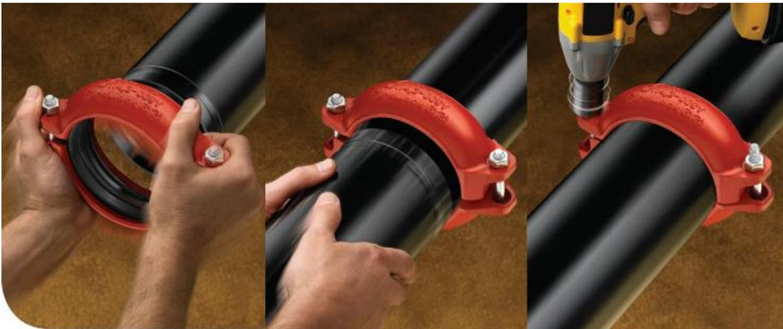
Figura 4.63 – Montaje de tuberías para sistemas ranurados (17)
