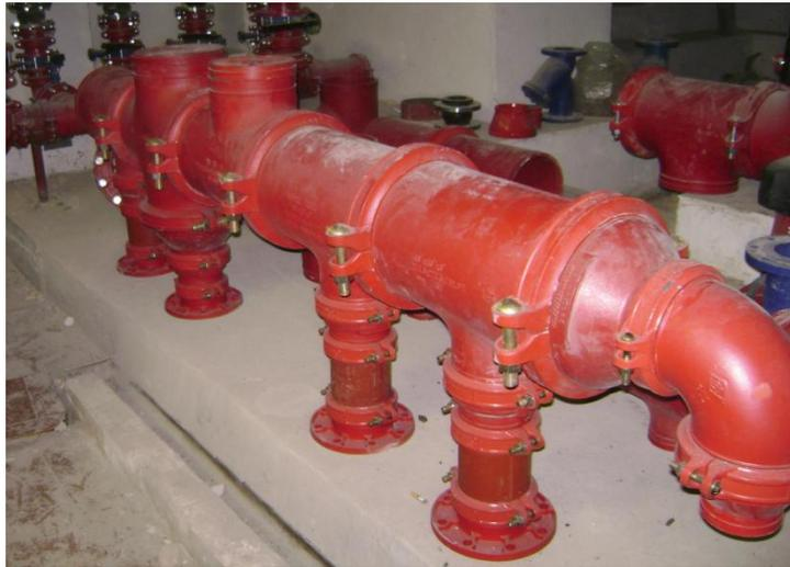
Figura 8.20 – Colector de una instalación
