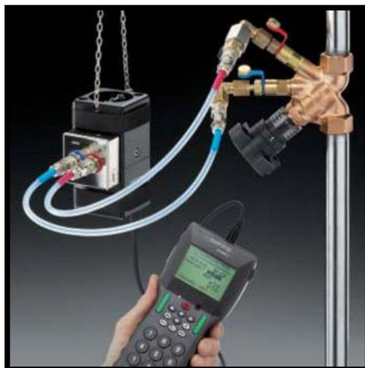
Figura 9.14– Ajuste de una válvula de equilibrado estático
