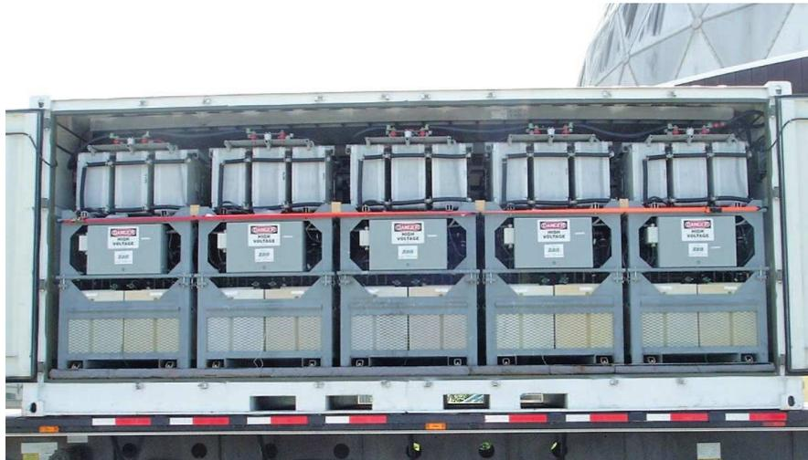
Figura 2.16. Baterías de flujo de Zinc-Bromo 1(500 kW, durante 2 horas).
