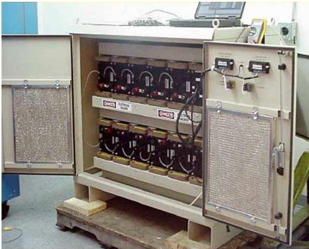
Figura 2.14. Sistema de almacenamiento Li-Ion de 100kW.
