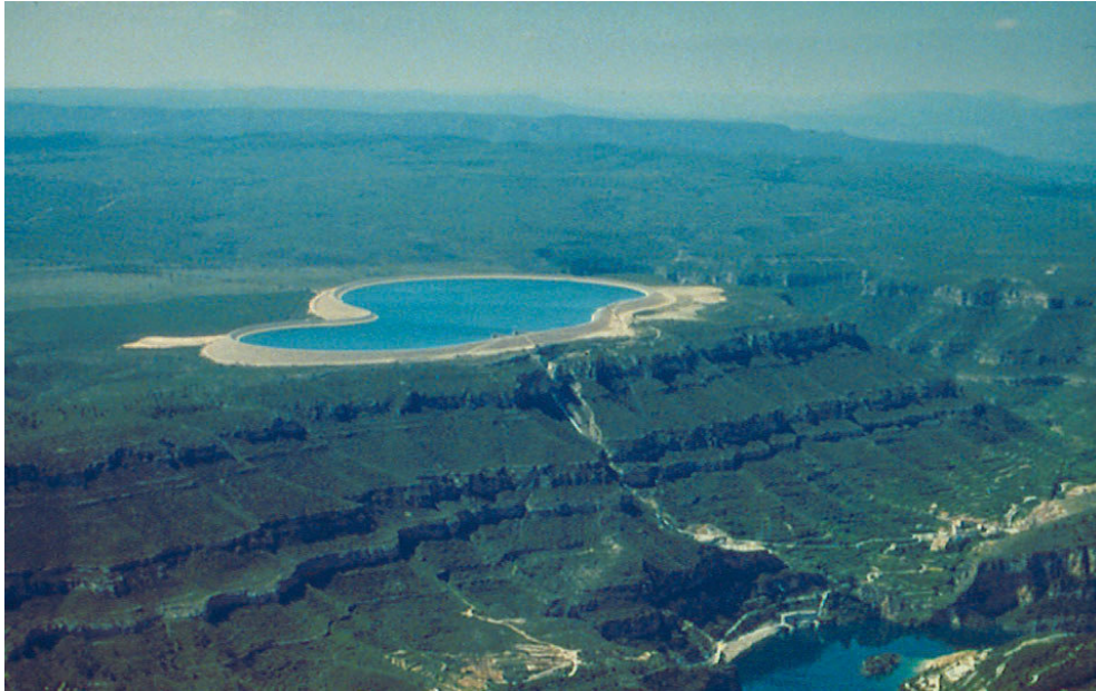
Figura 2.2. Embalse superior de la central de bombeo de La Muela.
