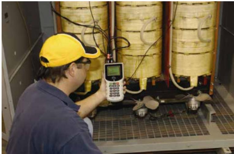
**Figura 4. 2. Unidad de medida de relación de transformación monofásica. Fuente: Megger.**
