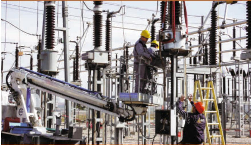
**Figura 1. 4. Inspección de un transformador de tensión de una subestación. Fuente: Endesa.**
