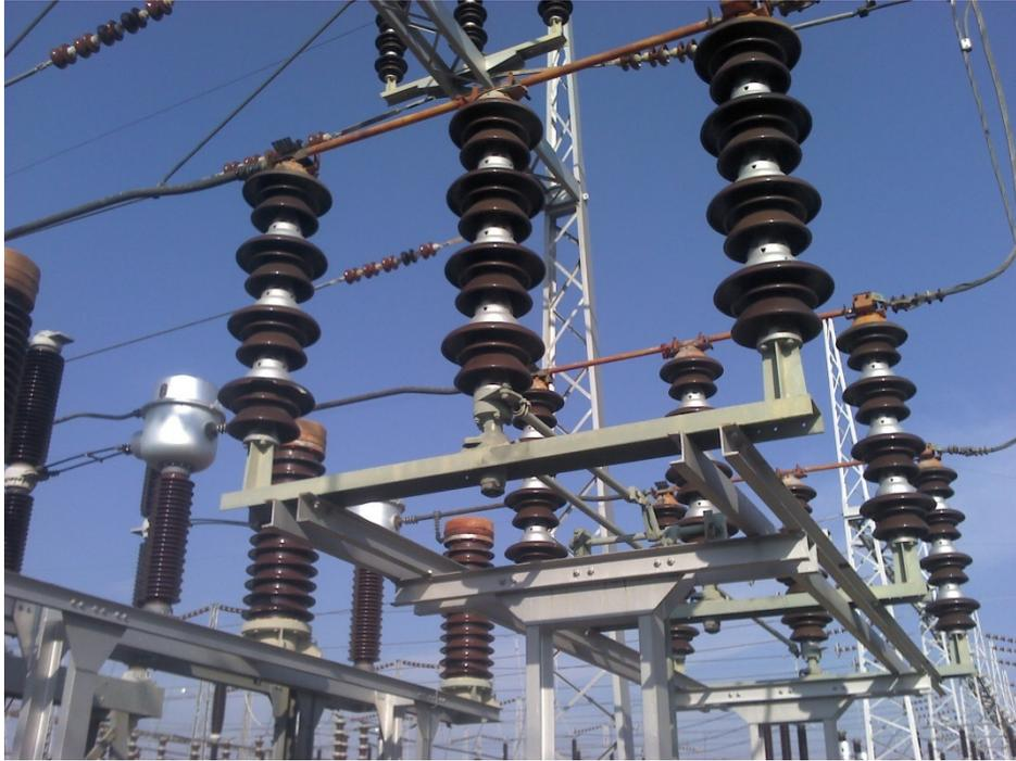
**Figura 3. 32. Seccionador de cuchillas giratorias. Fuente: Endesa.**
