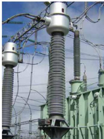
**Figura 3. 34. Transformador de intensidad. Fuente: ABB.**
