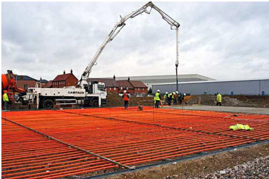
**Figura 28.-** La instalación de colectores solares en el patio de recreo en la Escuela Howe Dell captura el calor del verano para almacenarla en el suelo y liberarla para calefacción en invierno. Se duplica así el COP de la bomba de calor al precalentarla con un reservorio de calor.(ICAX)
