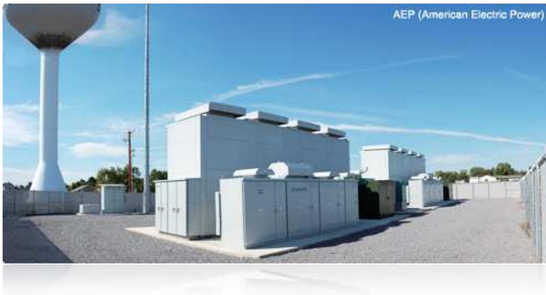
**Figura 20.-**AEP subestación de distribución con una unidad NaS.
