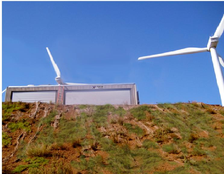
**Figura 18.-** Sistema de baterías de plomo ácido avanzadas "Dry Cell" de 1.5-MW/1-MWh de Xtreme Power empleado en un parque eólico.
