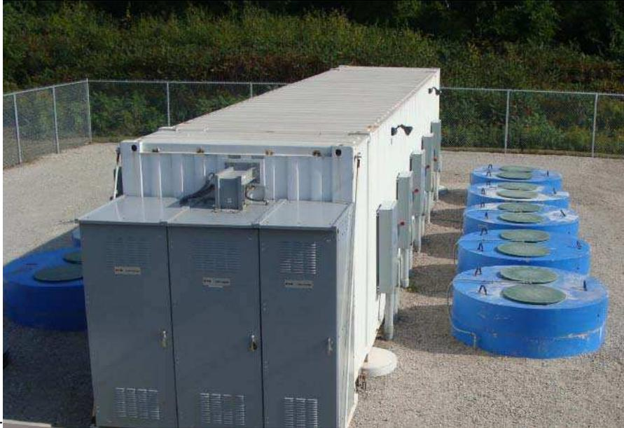
**Figura 25.-** Volantes de inercia de Beacon Power 1-MW/15-min. Aplicación auxiliary de regulación de frecuencia.
