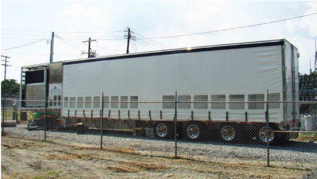
**Figura 23.-** TransFlow 2000 0.5-MW/2.8 MWh de Premium Power. Sistema de almacenamiento de energía móvil de ZnBr.
