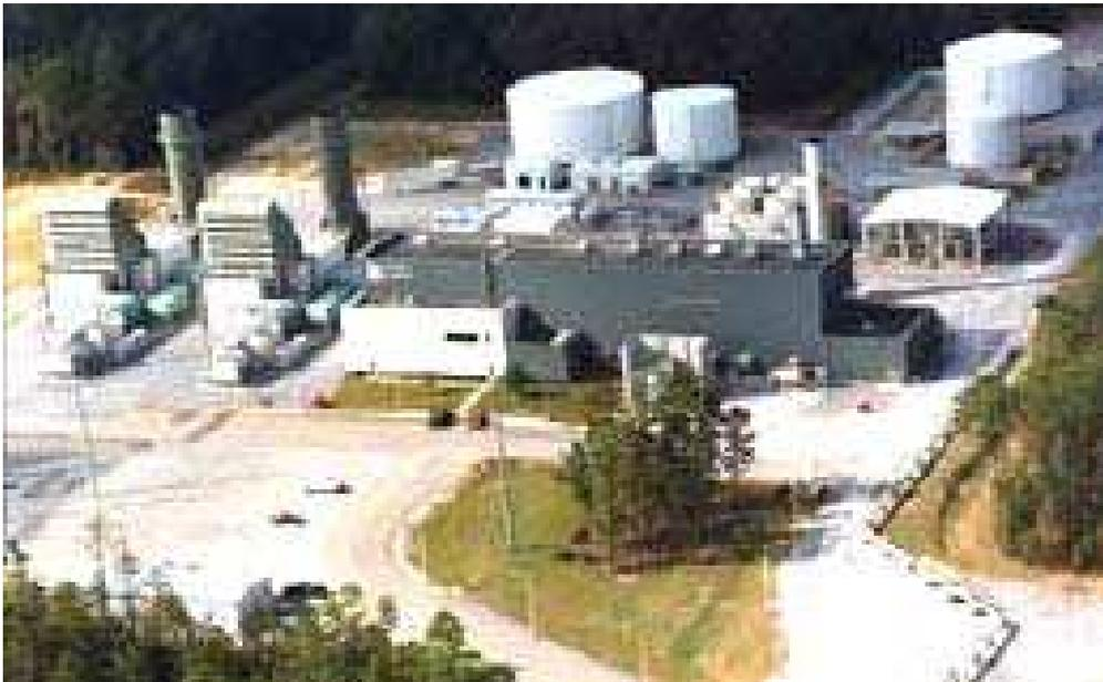
**Figura 15.-** Vista aérea de una planta CAES de almacenamiento bajo la superficie situada en McIntosh, Alabama, una de las dos plantas de este tipo que operan en el mundo. La otra se encuentra en Huntorf, Alemania.
