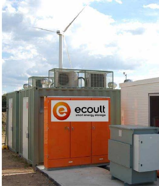
**Figura 17.-** Fase 1 de Ecoult 1-MW/1-MWh, sistema de ultrabaterías en el proyecto de integración de energía eólica en Hampton, Australia.
