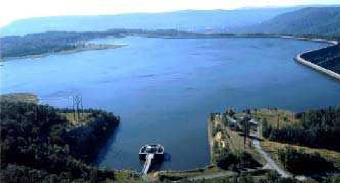
**Figura 13.-**Embalse artificial superior en Raccoon Mountain, central hidroeléctrica de bombeo operativa desde 1979. La instalación puede generar 1.620 MW durante un máximo de 22 horas.
