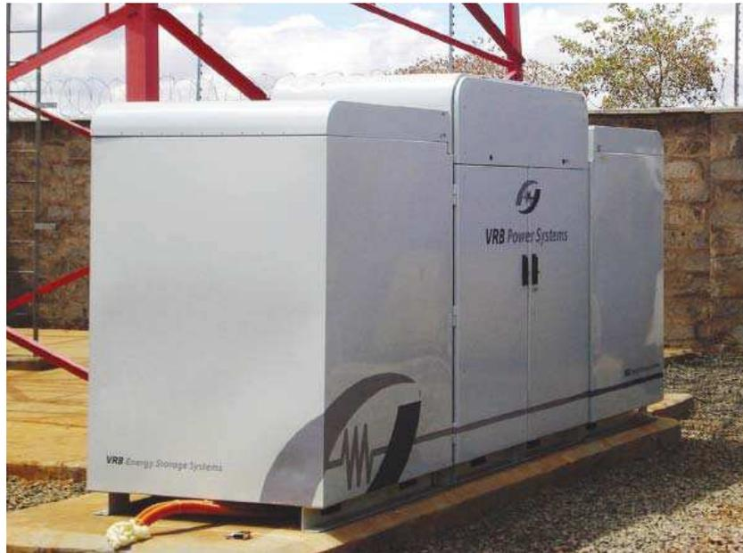
**Figura 21.-** Prudent Energy 5\_kW/30-kWh VRB-ESS instalado en Kitangi, Kenia. Trabaja junto a un generador diesel para constituir un sistema de potencia híbrido en un lugar aislado de la red.
