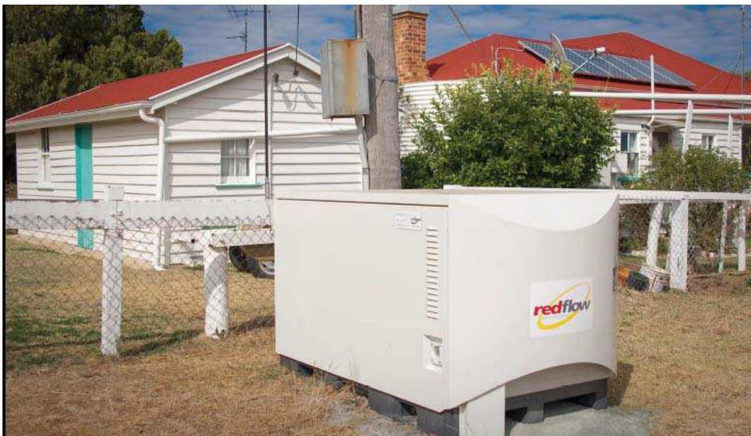
**Figura 22.-** Este 5-kW/20-kWh sistema comunitario de almacenamiento de energía (CES), de RedFlow Power y Ergon Energy en Australia estarán conectado a una Smart Grid para proporcionar almacenamiento a escala de megavatios en la red eléctrica.
