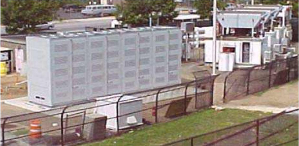
**Figura 19.-** Instalaciones de baterías NaS NYPA 1.2-MW/7.2-MWh.
