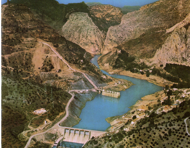
Figura 10.- Vista aérea de la instalación
