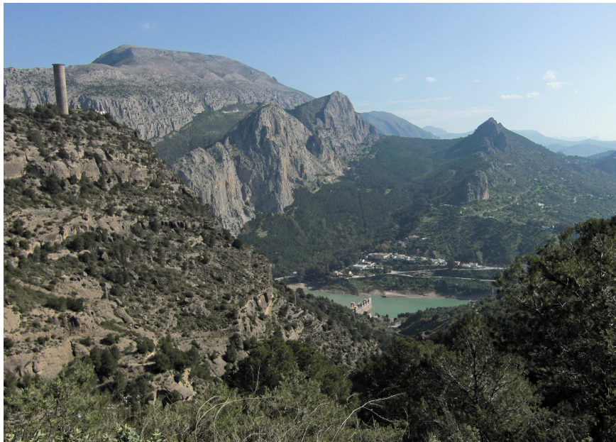
Figura 16.- Vista de la chimenea de equilibrio con la central al fondo.
