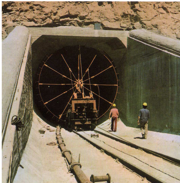
Figura 18.- Proceso de montaje de la tubería forzada
