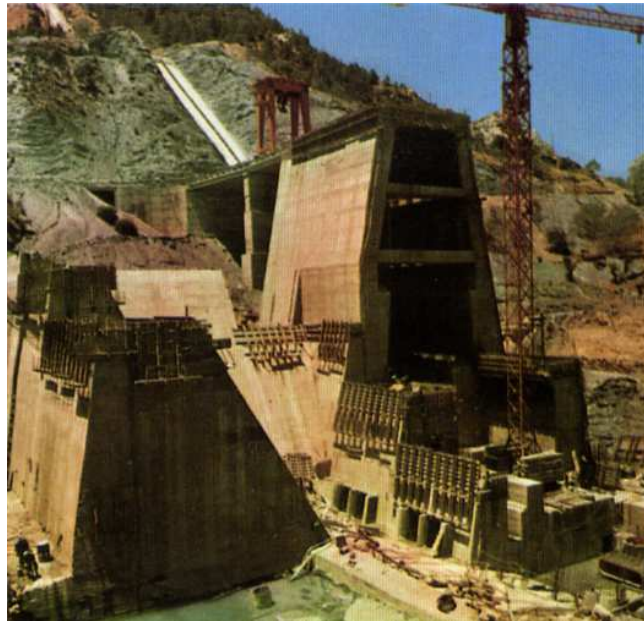
Figura 22.- Sección transversal de la central en fase de construcción.
