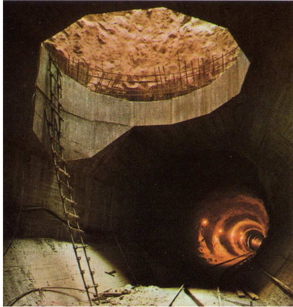
Figura 21.- Proceso de montaje de la chimenea de equilibrio.
