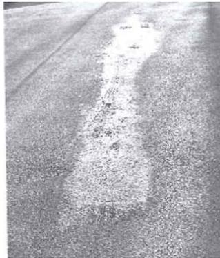
Fig. 10.4 Deterioro del firme por derrame de carburante y/o aceites
