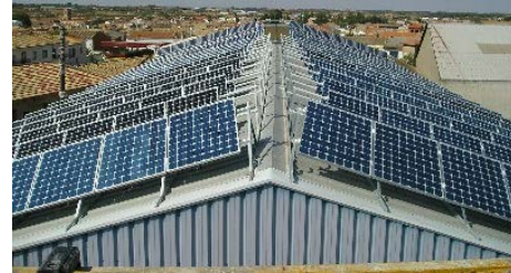
Sobre techo de nave
