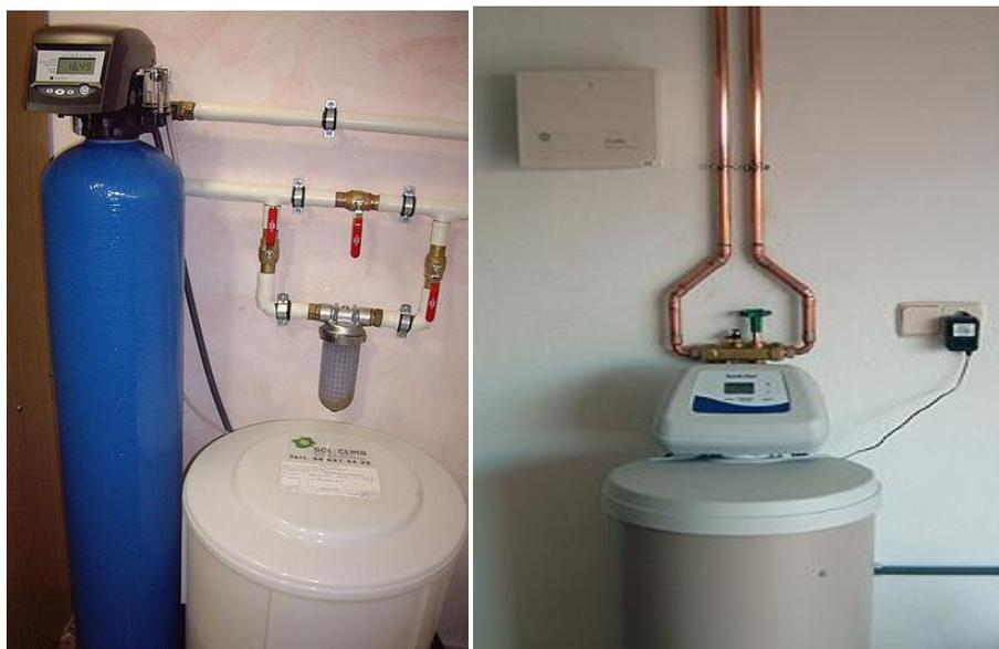
**Figura 14:** Ejemplos instalación doméstica de descalcificadores iónicos [25].
