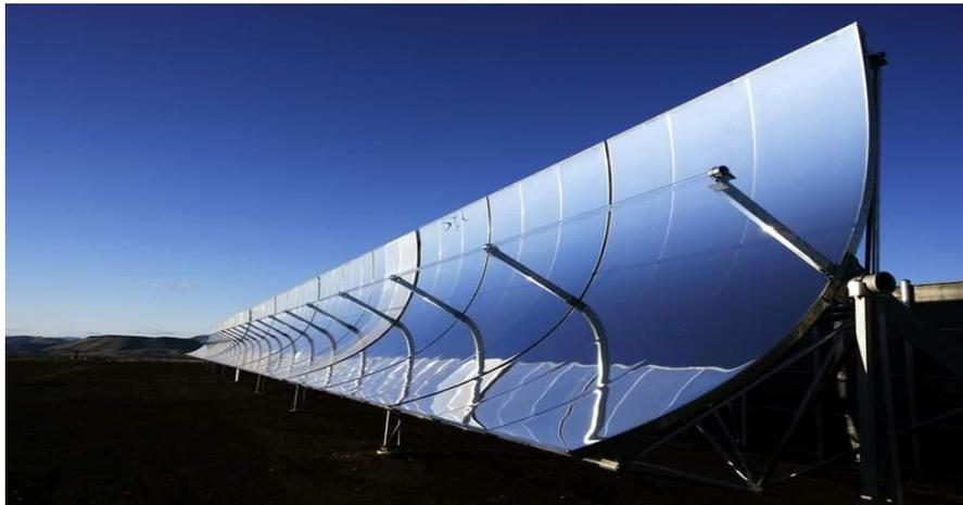
Figura 4. Tecnología Cilindroparabólica
