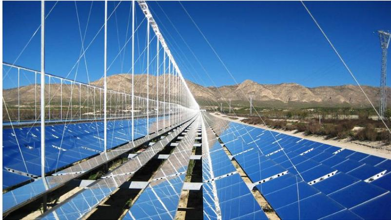
Figura 3. Concentradores Lineales Tipo Fresnel
