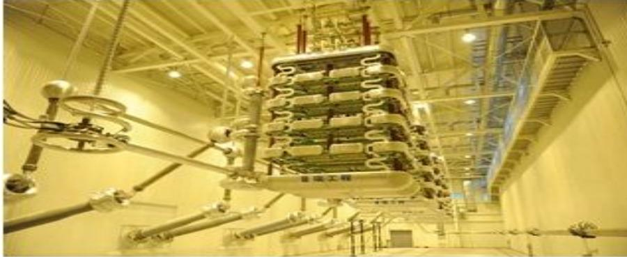
Figura 49. Sala de válvulas en el enlace Jinping I. Fuente: ABB
