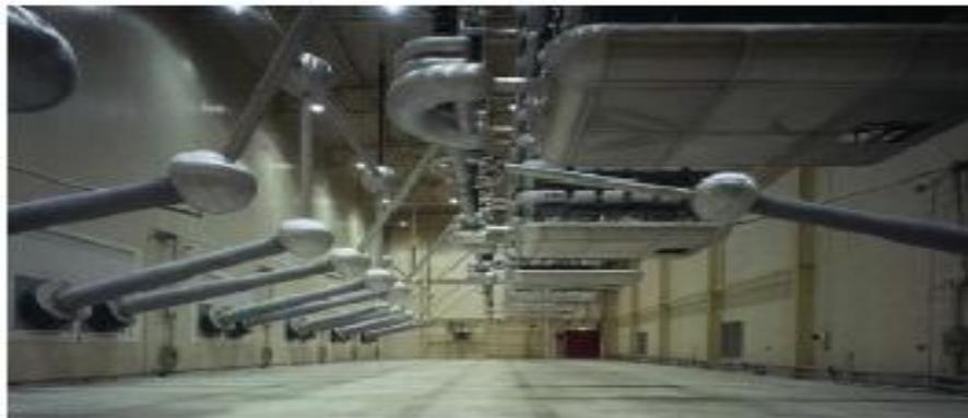
**Figura 46. Interior del edificio de válvulas de una de las estaciones de conversión. Fuente: ABB**
