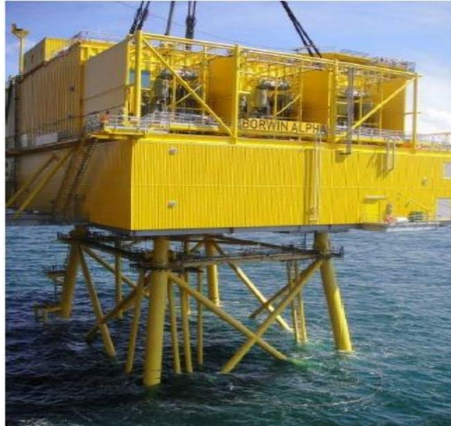
**Figura 56. Plataforma offshore del parque BorWin1. Fuente: ABB**
