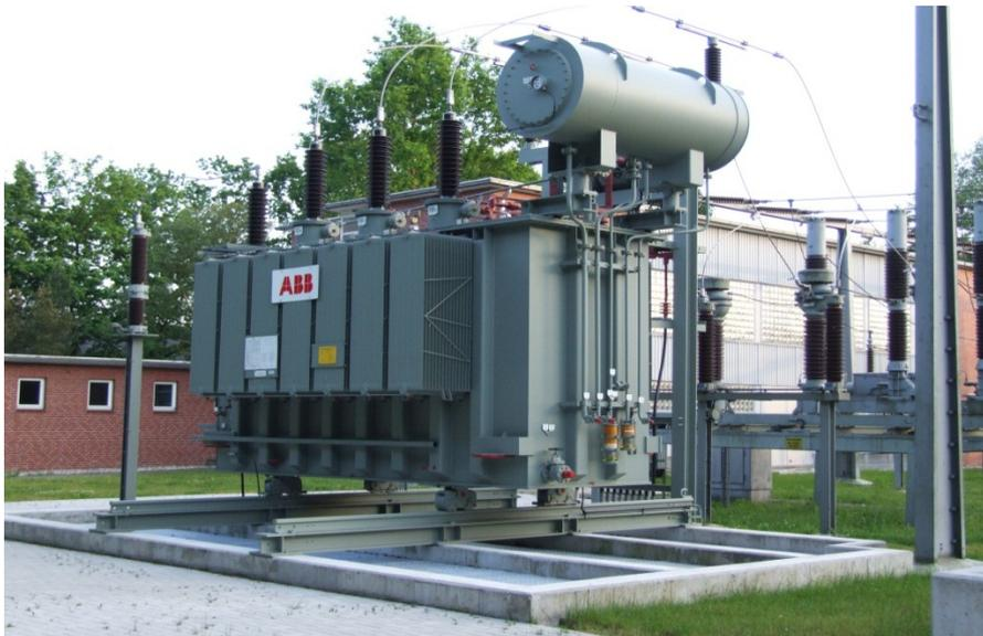
**Figura 11. Transformador de corriente alterna de la compañía ABB. Fuente: ABB**
