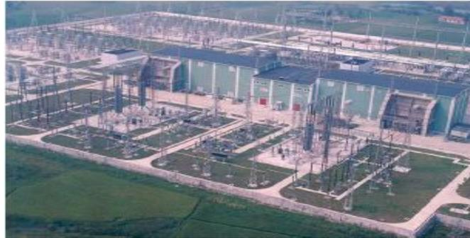
**Figura 45. Estación de conversión de uno de los enlaces HVDC. Fuente: ABB**
