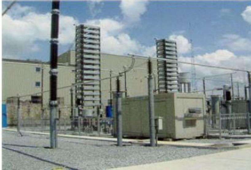
Figura 10. Filtro de corriente continua en una instalación. Fuente: ABB
