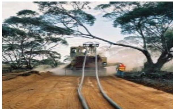
Figura 54. Colocación de cables en el enlace Murraylink. Fuente: ABB
