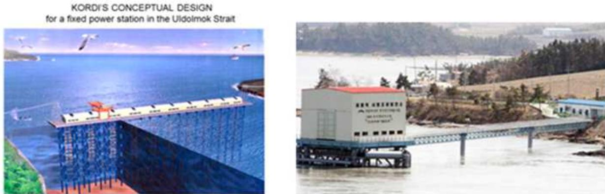
Ilustración 51: Planta de turbinas helicodales en el estrecho de Uldolmok en Korea
