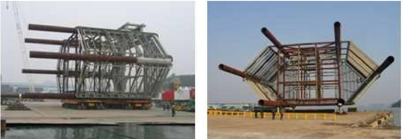
Ilustración 27: Estructura portante de turbinas utilizada en el estrecho de Uldolmok.
