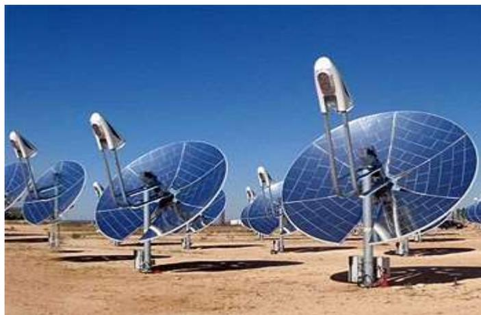
**Ilustración 6. Discos parabólicos.**
