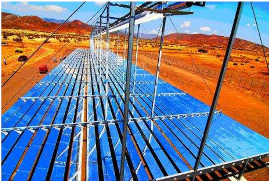
**Ilustración 2. Receptores lineales Fresnel.**
