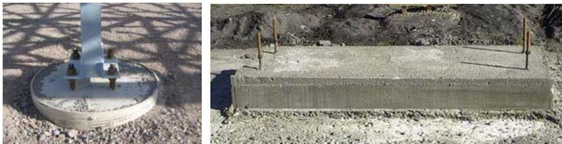
Fig. 2.6: Cimentaciones de colectores cilindro-parabólicos
