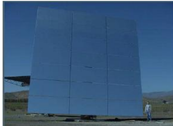
Fig. 1.3: Heliostato de vidrio-metal de 90 m 2 de superficie-reflexiva.
