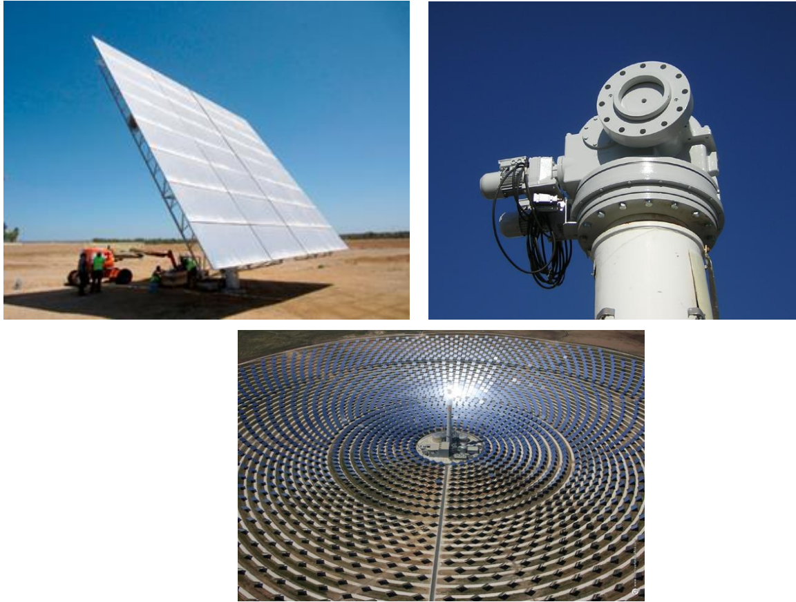
Figura 10. Helisotato, sistema de seguimiento y campo solar (Gemasolar). Fuente: Abengoa
