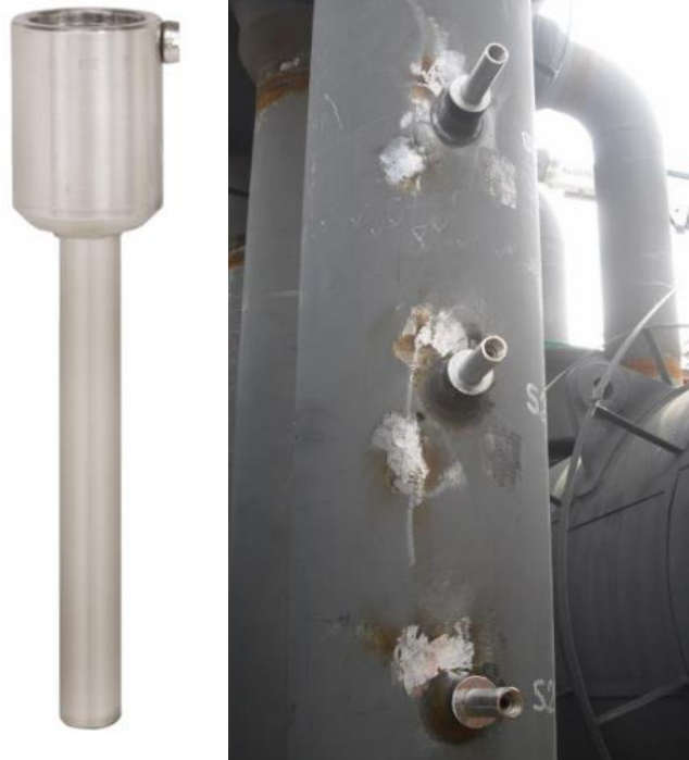
Figura 42. Elemento primario soldado (catálogo e instalación).
