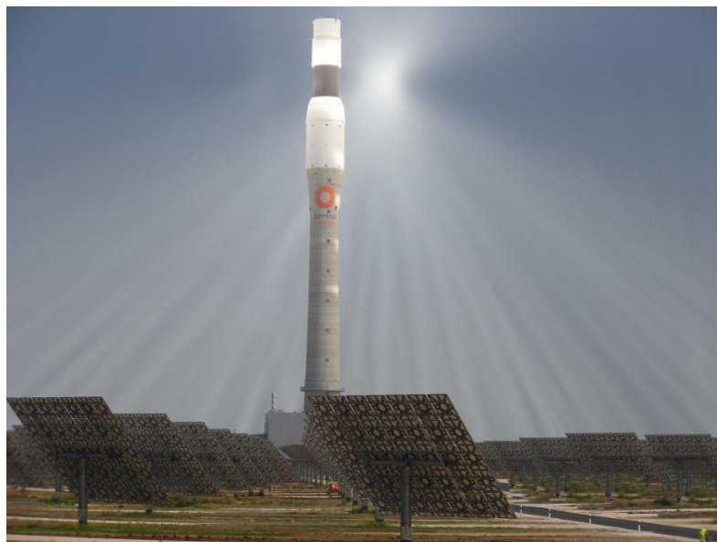
Figura 12. Receptor y campo solar de Gemasolar. Fuente: Torresol Energy.
